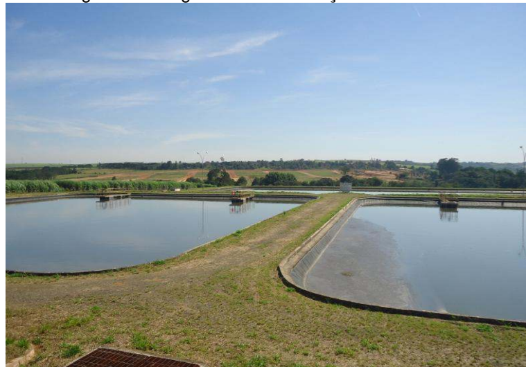
Figura 18 - Lagoas de estabilização - ETE Balsa.
