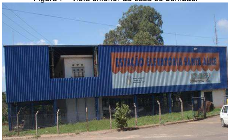
Figura 7 - Vista exterior da casa de bombas.
