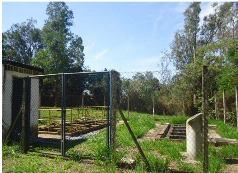
Figura 24 - Acesso à ETE Andorinhas.
