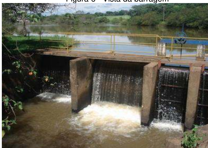
Figura 6 - Vista da barragem
