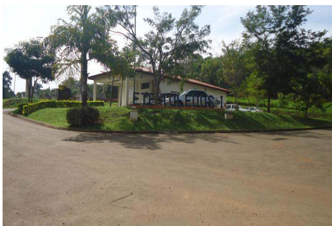
Figura 16 - Acesso à Estação de Tratamento de Esgoto Toledos I.
