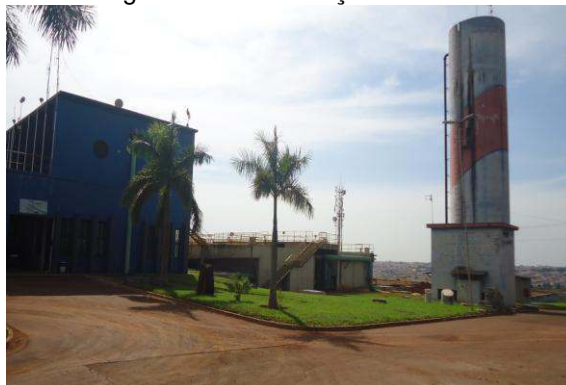
Figura 11 - Localização ETA IV.
