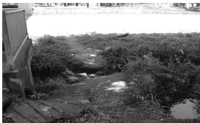
Passarela e margens da Rodovia SP-304 (Luiz de Queiroz) dos bairros Jardim Gerivá e Jardim dos Cedros.
