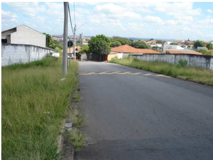
(Fls. 02 – Limpeza e construção de calçadas em terrenos localizados na Rua Joaquim Benedito do Amaral, no bairro Santa Inês)
