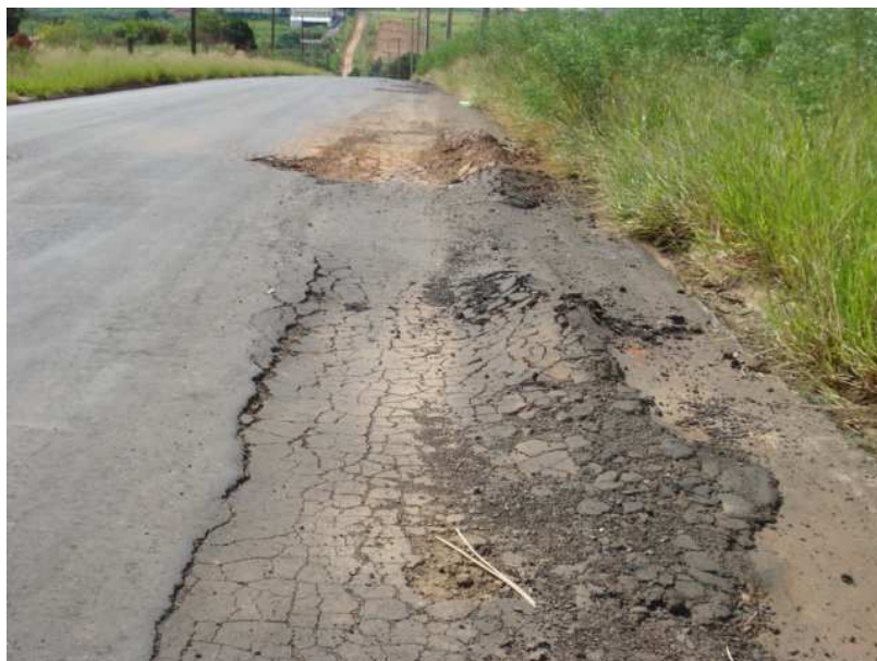
(Fls. 02 – Reparo da camada asfáltica na Estrada da Cachoeira, no bairro Residencial São Joaquim)
