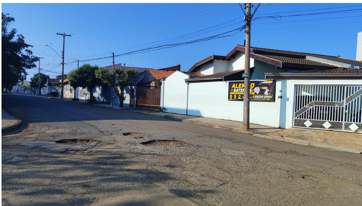
Rua Mococa, cruzamento com Rua Egídio Barbosa.
