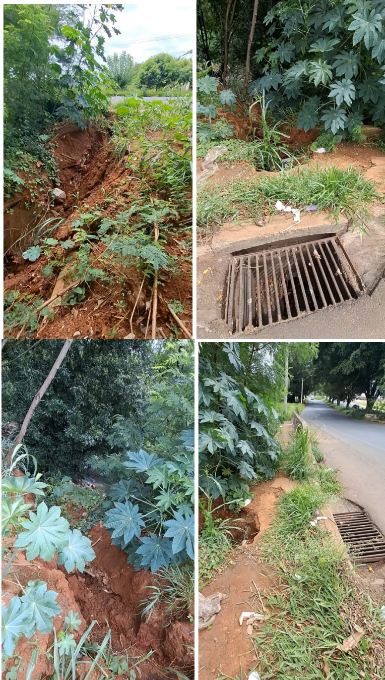
Erosão na ponte sobre Córrego Mollon, na Avenida Antonio Pedroso
