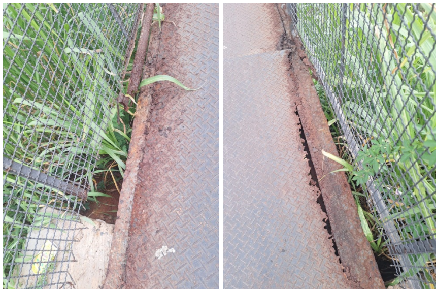
Condições da passarela metálica de pedestres no bairro São Joaquim.
