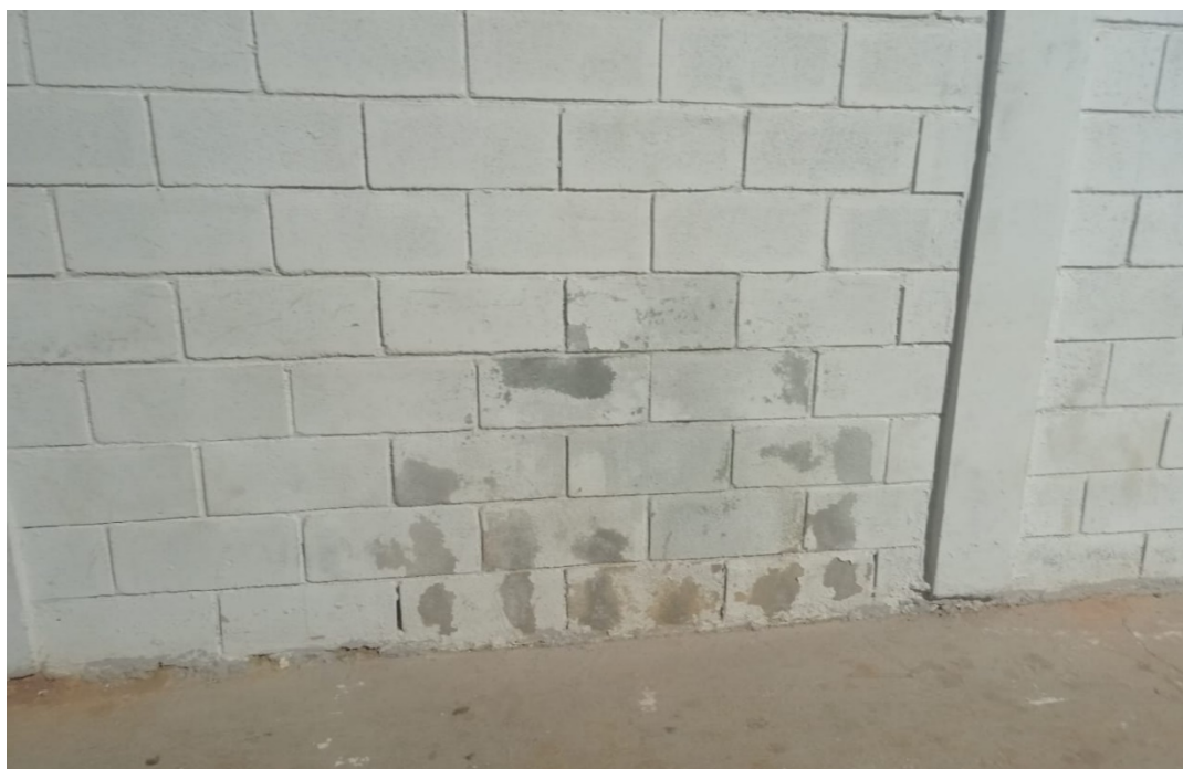
Infiltração Parede externa banheiro PNE
