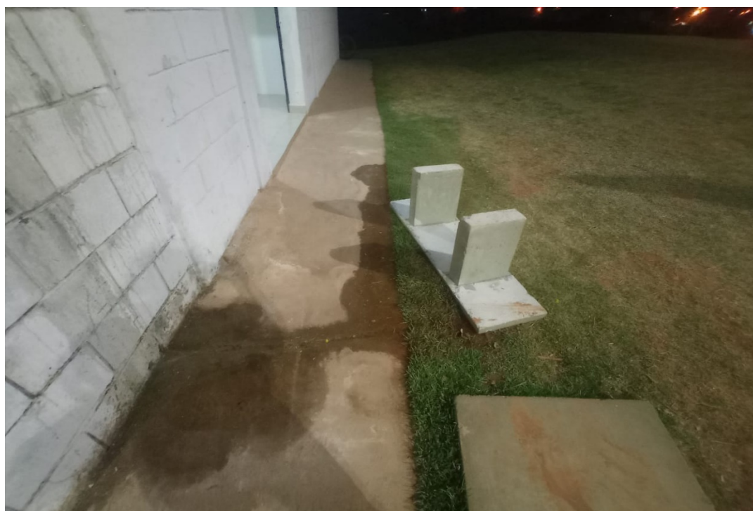
Vazamento constante de água
