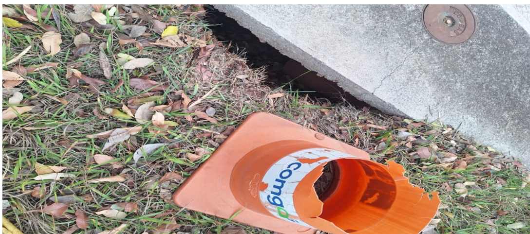
Erosão na Central de Distribuição da Comgás no Jardim São Francisco
