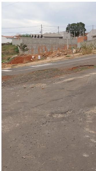
Conforme foto acima, devido às chuvas e com o movimento de veículos, houve deterioração da camada asfáltica, necessitando da urgente execução do serviço supracitado, visando manter a boa conservação urbana e segurança do trânsito.
