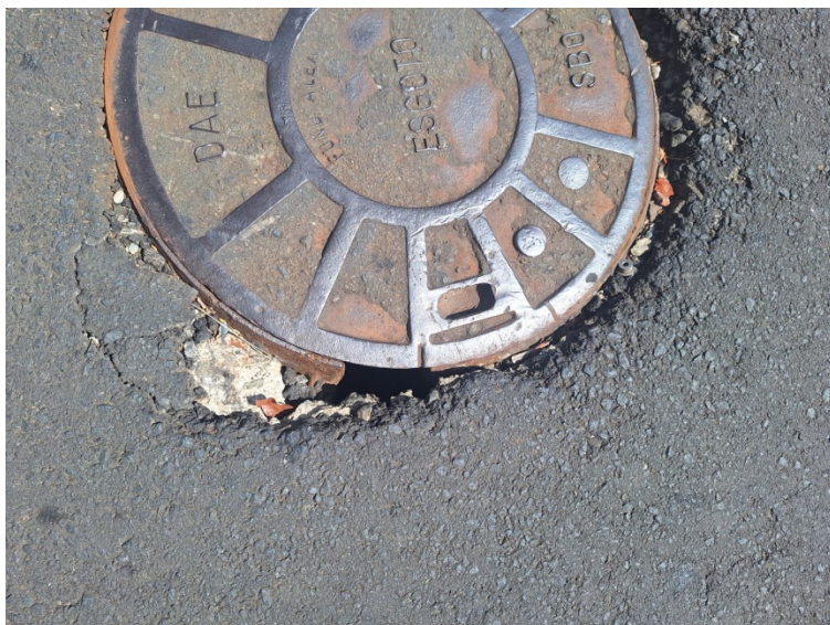
Erosão ao redor da tampa do poço de visita – Rua Lituânia, 96, Jardim Europa IV
