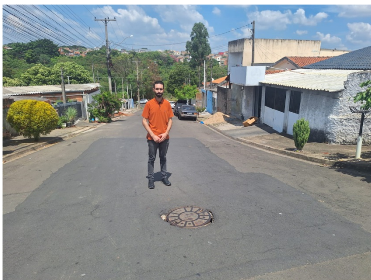
Poço de visita na frente do número 96 com erosões ao redor – Rua Lituânia
