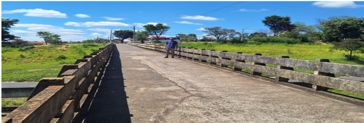
Passarela sem tela e gaiola de proteção
