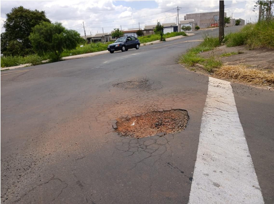
Conforme foto acima, este vereador pôde constatar o estado de degradação da malha asfáltica da referida via pública, fato este que prejudica as condições de tráfego e potencializa a ocorrência de acidentes, bem como o surgimento de avarias nos veículos automotores que por esta via diariamente
