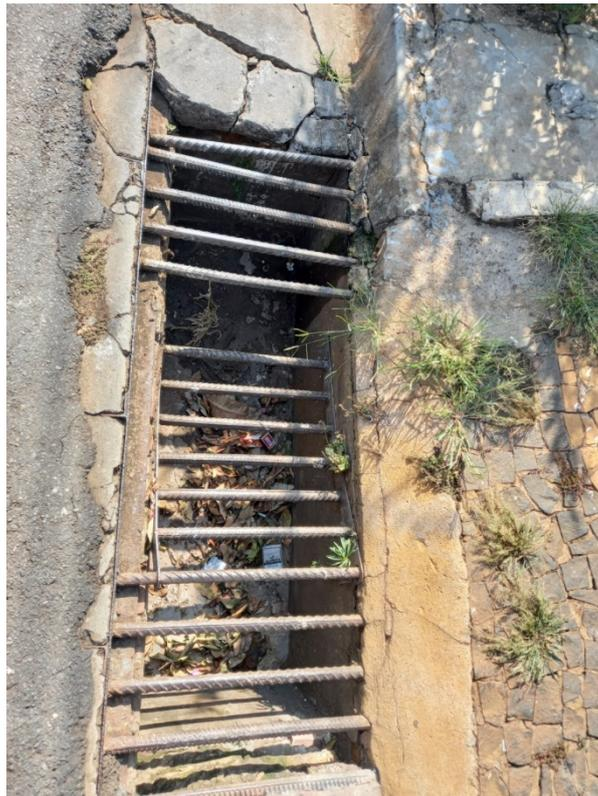
Conforme foto, verifica-se a falta de barras na grade além de afundamento da mesma, motivo pelo qual solicitamos a urgência manutenção da mesma, ou troca do objeto.
