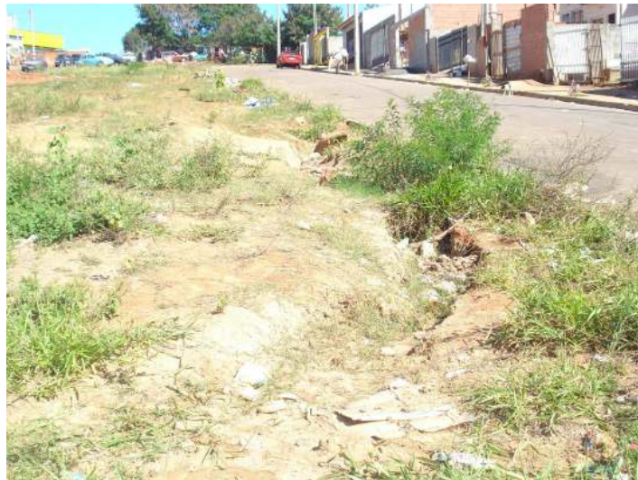
Construção da Calçada, na Avenida João Benedito Machado, no bairro Santa Fé
