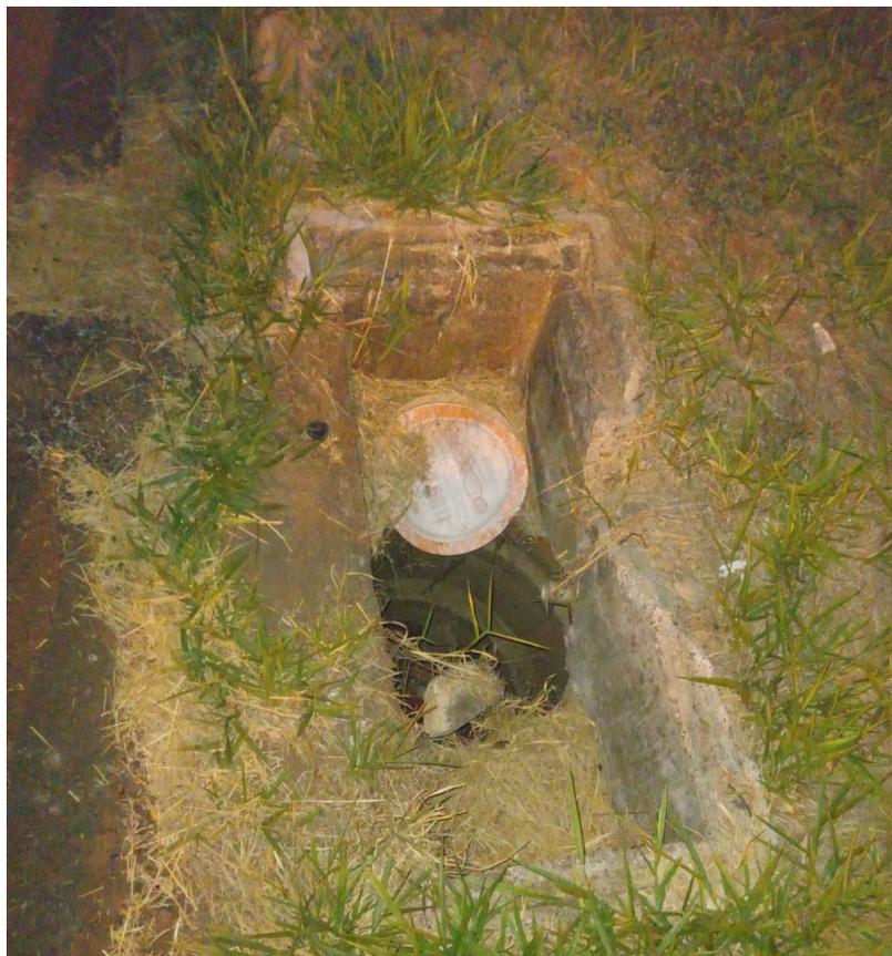
Conforme foto acima, solicitamos o devido conserto da tampa de bueiro, ora inexistente no local, evitando riscos de acidentes e quedas.
