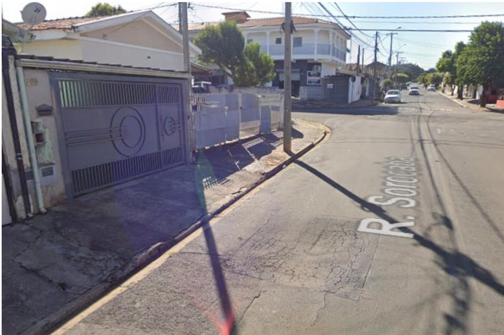
Conforme foto acima, o DAE fez serviço de reparo na rede de água e esgoto, no entanto, após o recape, o asfalto vem apresentando afundamento da malha asfáltica, trazendo riscos de danos materiais aos veículos e acidentes, além de acumular água parada, motivo pelo qual solicitamos urgência na execução do mesmo, visando manter a boa conservação urbana e evitar riscos a saúde pública com criadouro do mosquito da dengue.
