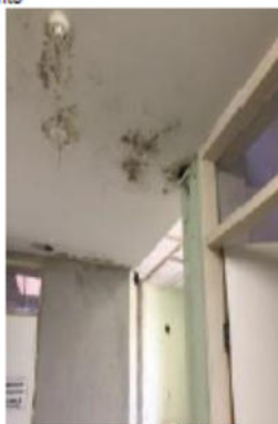
Sinais de vazamentos e infiltrações
