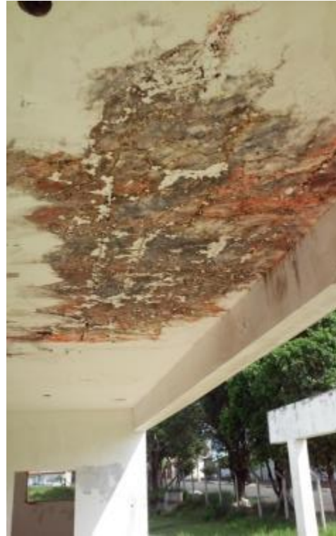
Sinais de infiltração no teto
