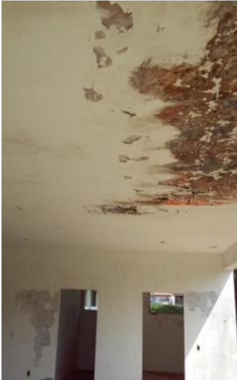
Sinais de infiltração no teto
