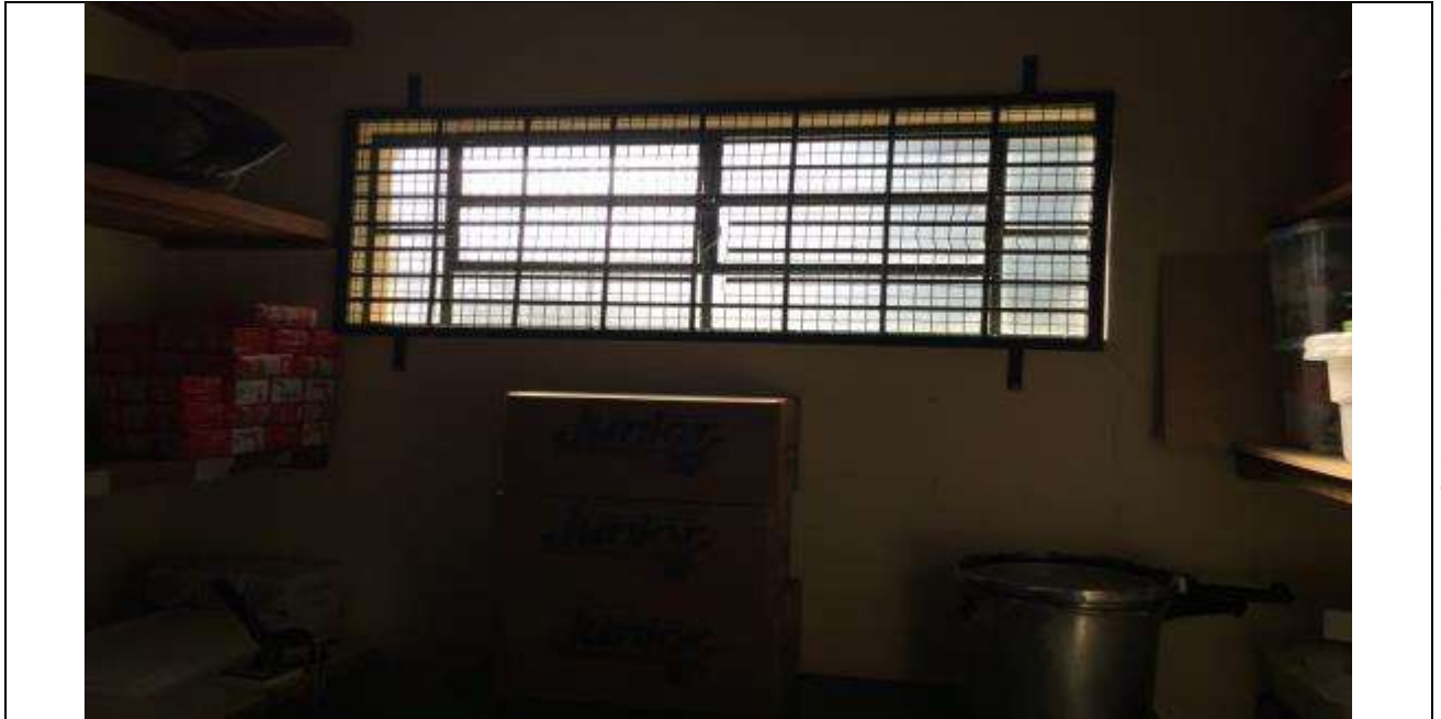
Espaço destinado ao armazenamento dos alimentos com janelas desprovidas de telas milimetradas.
