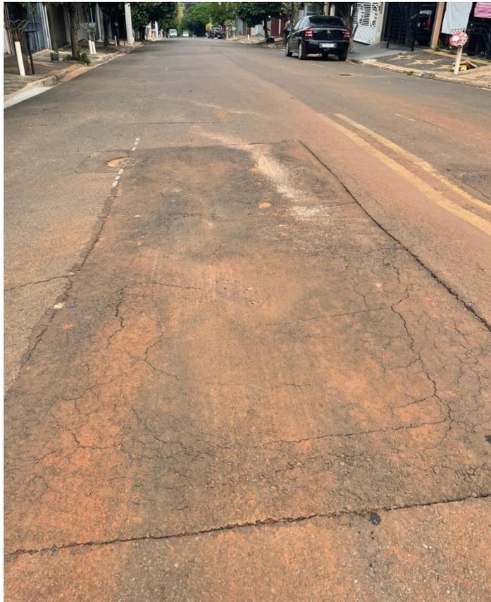
Conforme foto acima, o DAE fez serviço de reparo na rede de água e esgoto, no entanto, após o recape, o asfalto vem apresentando afundamento da malha asfáltica, trazendo riscos de danos materiais aos veículos e acidentes, motivo pelo qual solicitamos urgência na execução do mesmo, visando manter a boa conservação urbana.
