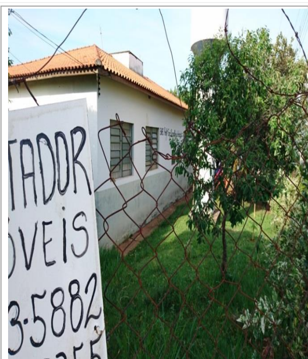
Necessidade de Limpeza externa
