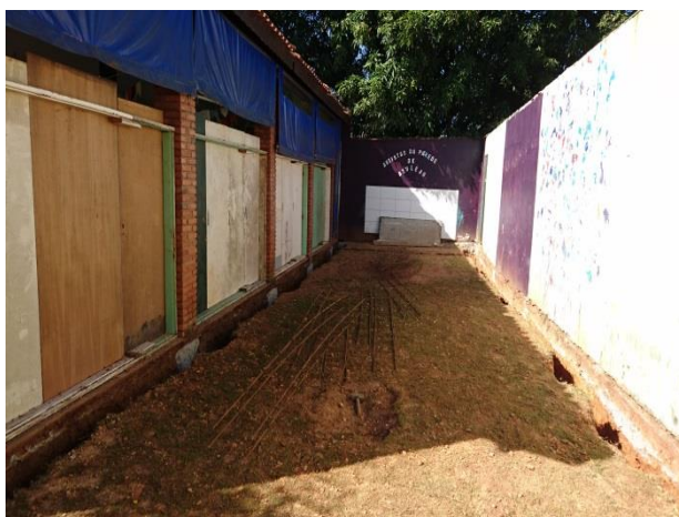
Ampliação em andamento
