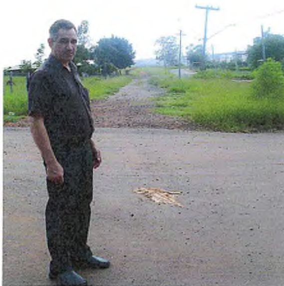
Rua que necessita de pavimentação.
