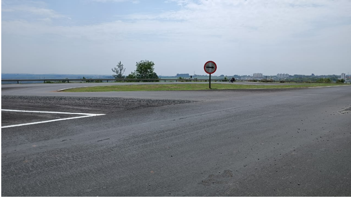
Trecho da SP 135 – Rotatória próximo as Indústrias Romi – Sentido Bairro Cruzeiro do Sul
