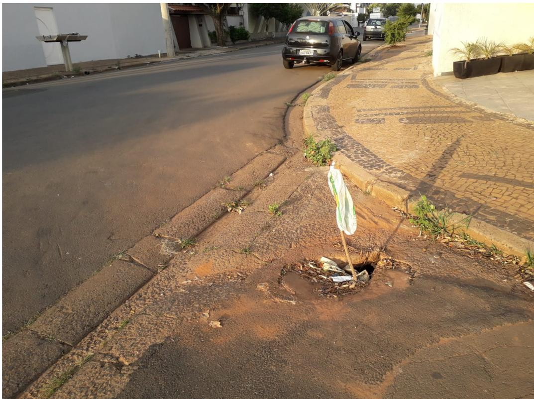
Conforme reivindicação da população e foto acima, há um grande buraco na malha asfáltica que vem aumentando dia a dia, necessitando de recapeamento da via pública, visando manter a boa condição do trânsito e sem riscos de acidentes e avarias.
