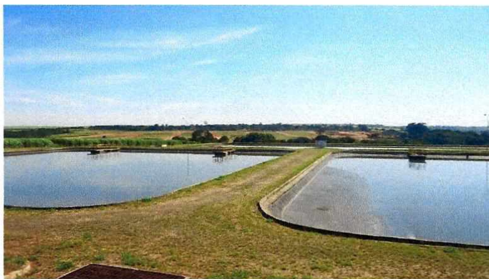
Figura 27 - Lagoas de estabilização - ETE Balsa.
