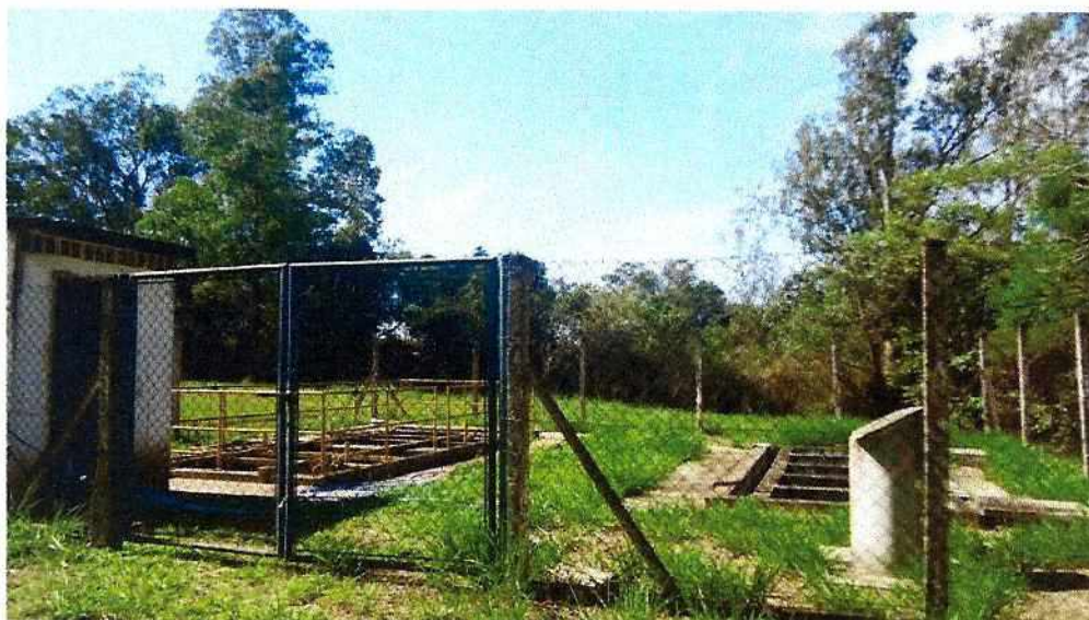
Figura 34 - Acesso à ETE Andorinhas.
