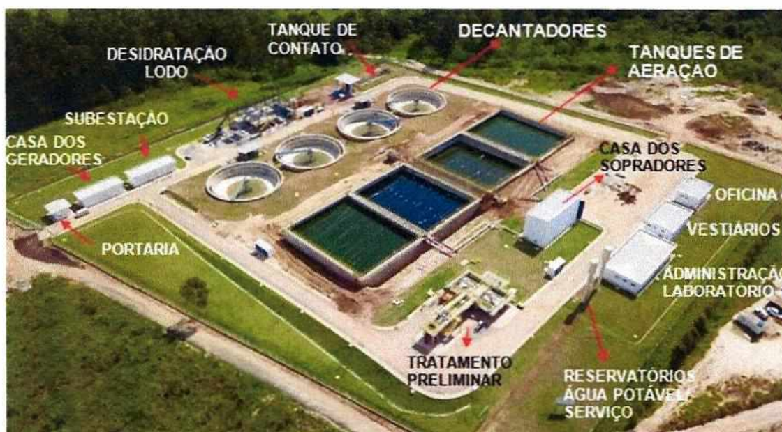
Figura 37 - Vista Aérea ETE Toledos II
