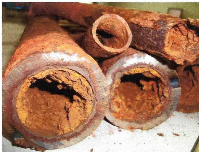
Figura 17- Tubulações de ferro fundido retiradas da região central
