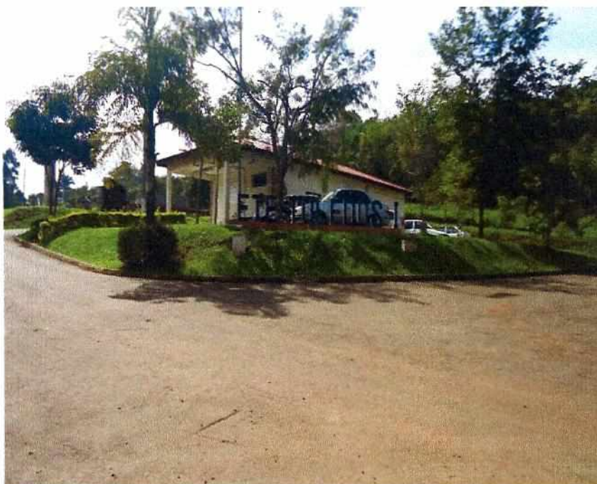
Figura 25 - Estação de Tratamento de Esgoto Toledos I.
