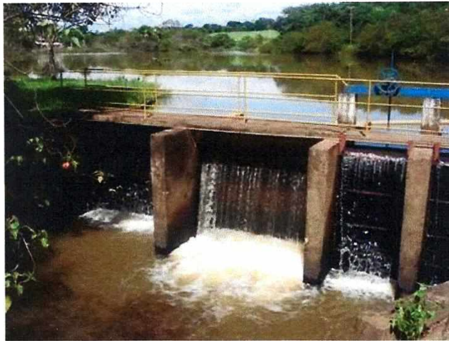
Figura 9 - Vista da barragem
