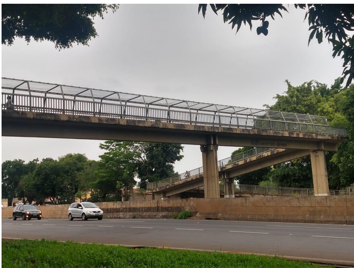
Passarela sobre a SP-304, interligando os bairros Jardim Brasília e Mollon
