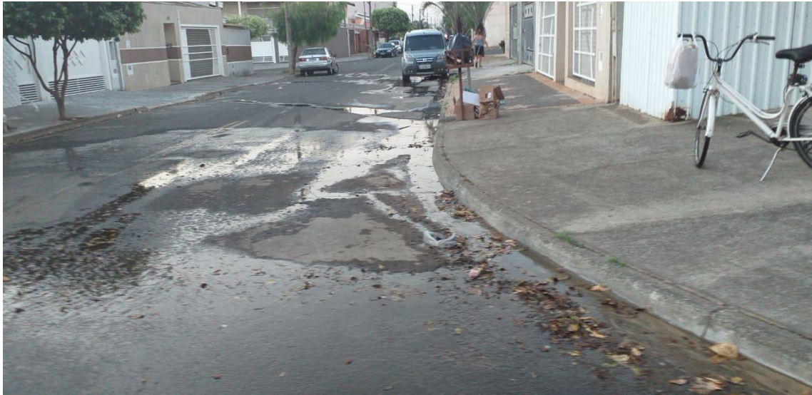
Rua Padre João Rodrigues fica alagada.
