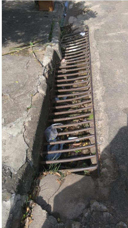
BUEIRO DEFRENTE AO Nº 624
