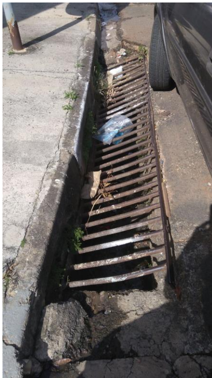
BUEIRO DEFRENTE AO Nº 660
