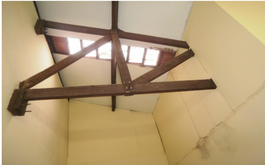
Telhado da cozinha
