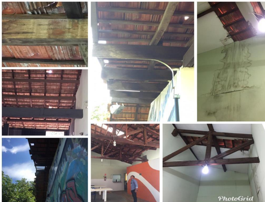
Telhado do prédio
