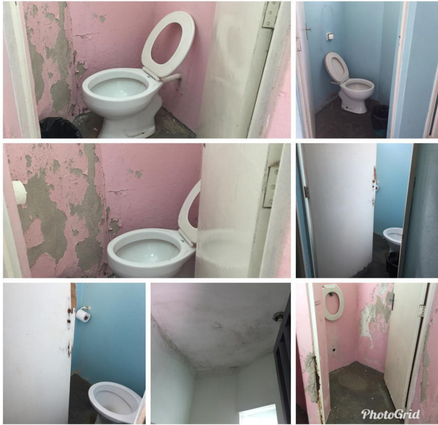
Área do Banheiro masculino e feminino
