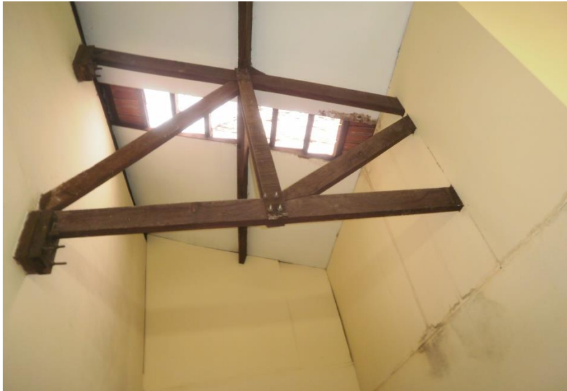
Telhado da cozinha
