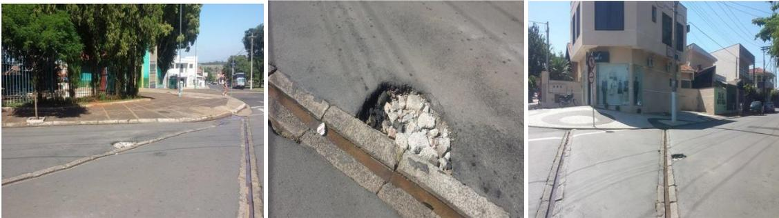
Conforme solicitação dos moradores do bairro e demais condutores de veículos que trafegam pela referida via, solicito reparo na camada asfáltica do local acima indicado, uma vez que tal problema vem causando transtornos aos munícipes, devido as grandes crateras formadas pela força da enxurrada das chuvas dos últimos dias.
