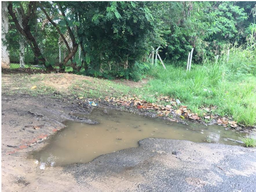
Conforme foto acima, este vereador pôde constatar que a malha asfáltica no endereço supracitado está danificada, causando empossamento e água parada. Diante a situação solicito a execução dos serviços de tapa buraco, visando manter a conservação e bom estado da malha asfáltica.
