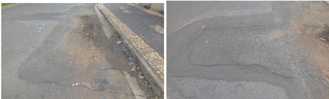
Conforme relatos dos moradores locais e visita “*in loco*”, verificamos que pela Rua Monte Gerezin, altura nº 200 - Jardim Alfa, existem buracos na massa asfáltica, sendo que foram abertos para reparos na rede de água e esgoto, buraco aberto pelo DAE – Departamento de Água e Esgoto, deixando a massa asfáltica danificada, onde até acidentes no local houve com motociclista, necessitando de reparos urgentes.
