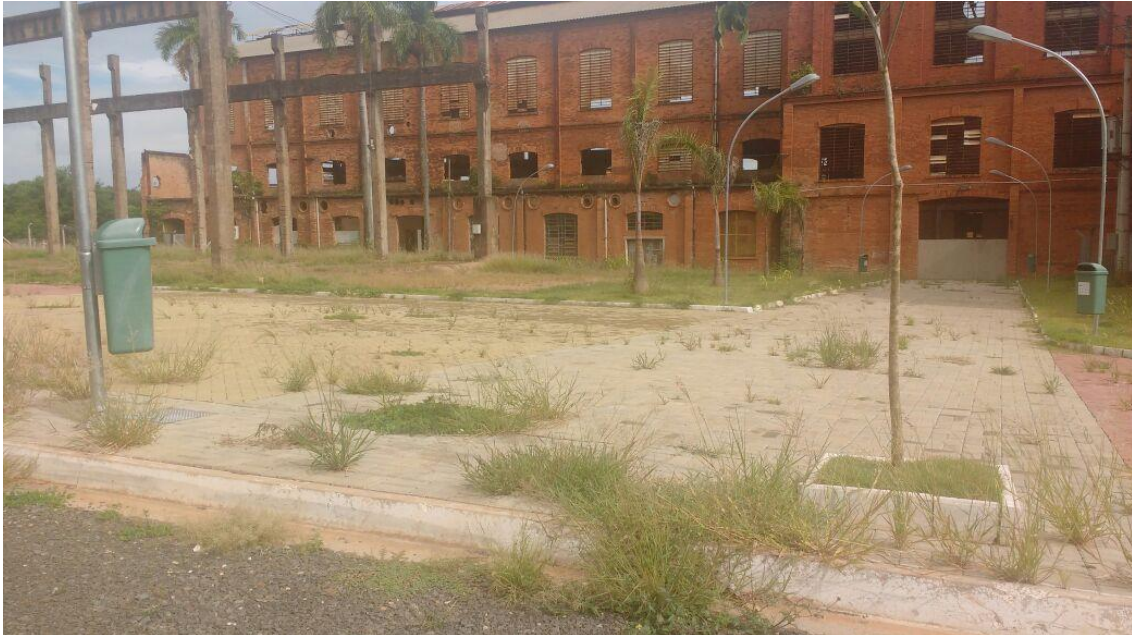
Usina Santa Bárbara
