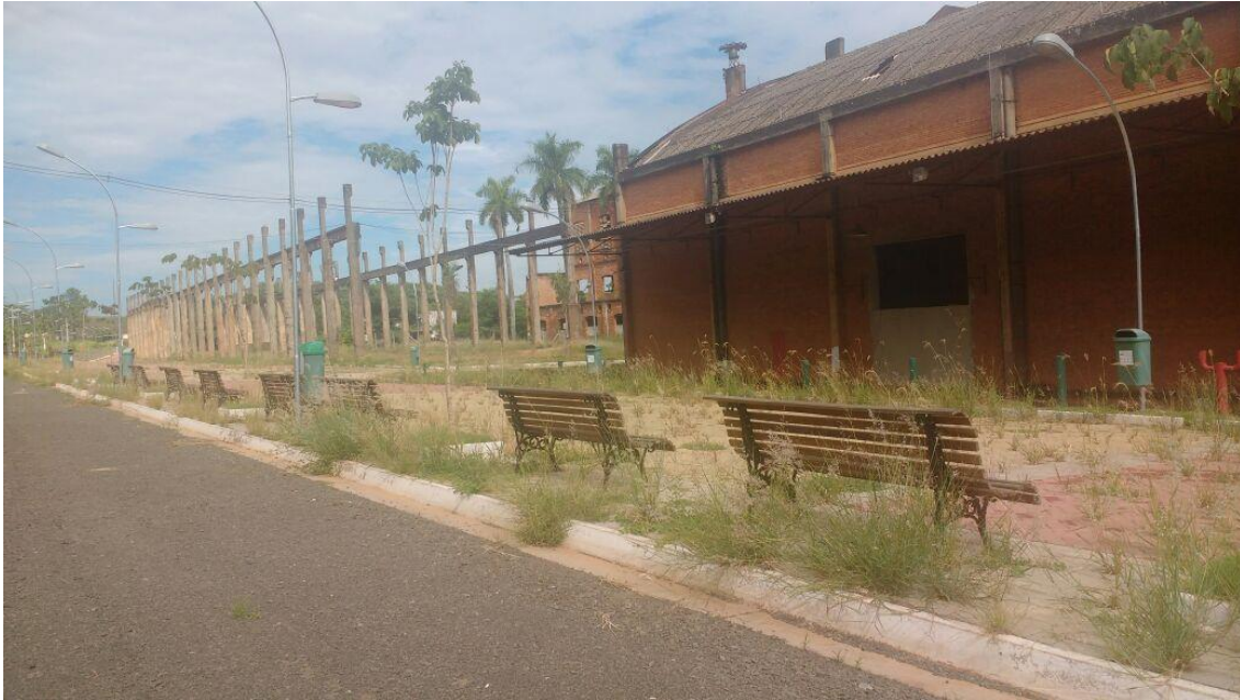
Usina Santa Bárbara
