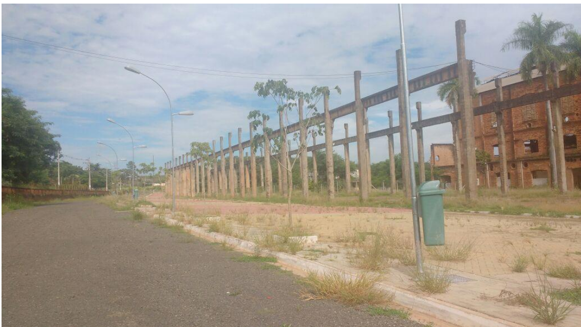
Usina Santa Bárbara
