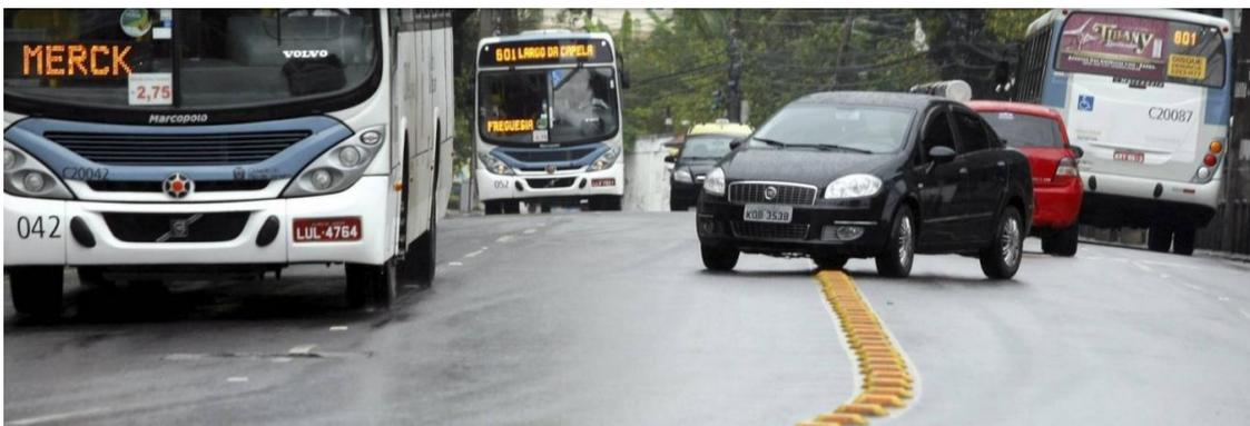
Ilustração de Faixa Dupla Contínua com Tachões a ser instalada no local
