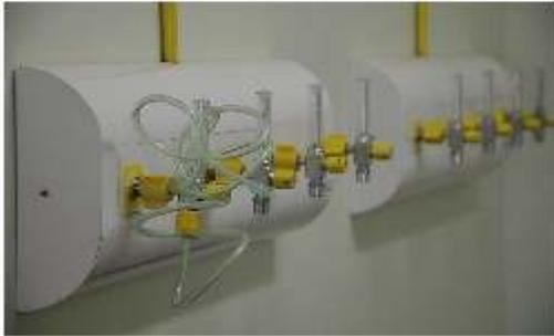
Dutos de inalação culminam em compressores de ar armazenados em más condições ao invés de cilindros.
