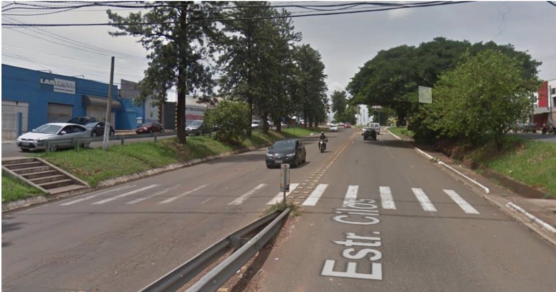
(Trecho para continuação da defesa metálica)
