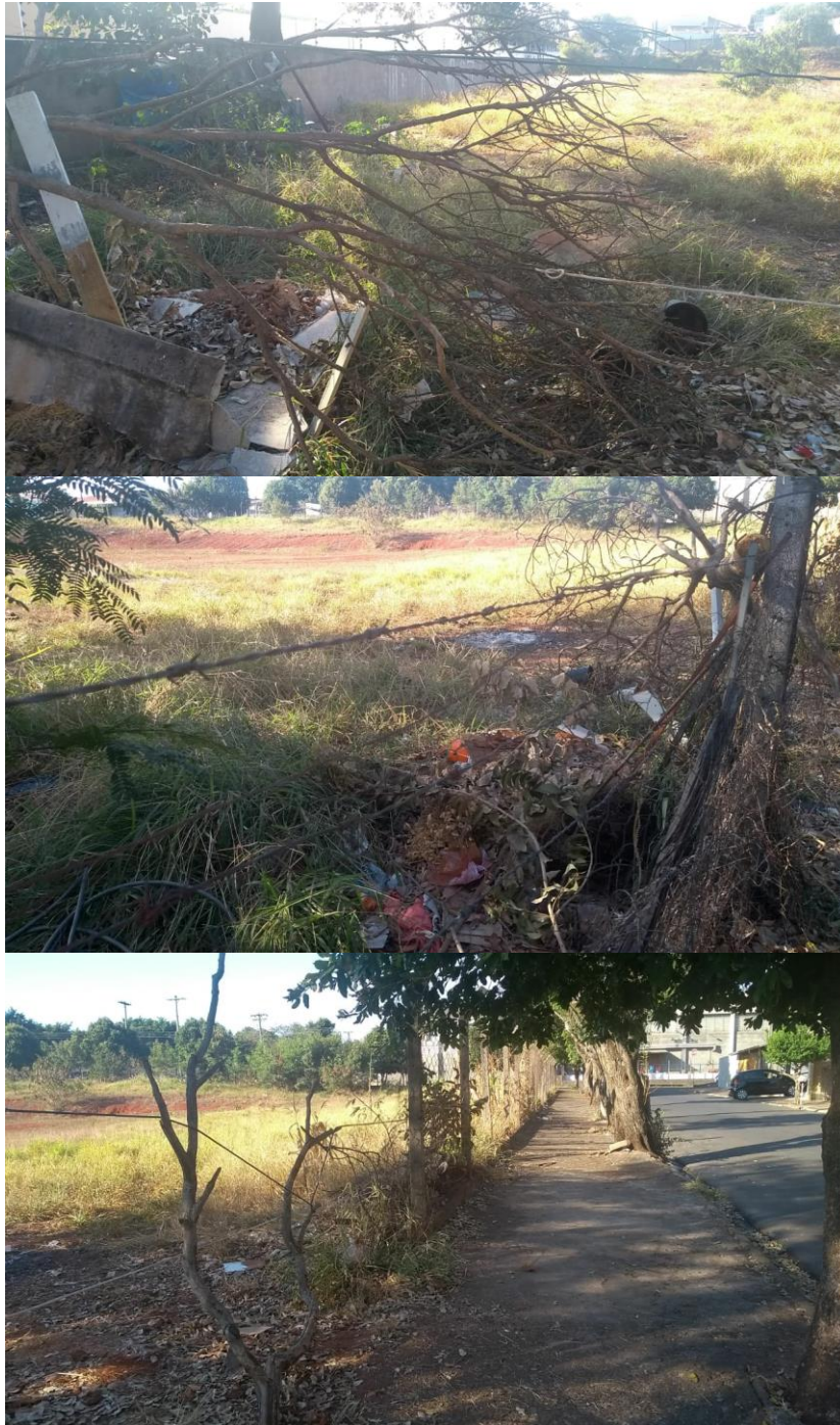
Local que consta a abertura no alambrado e precisa ser fechado.
