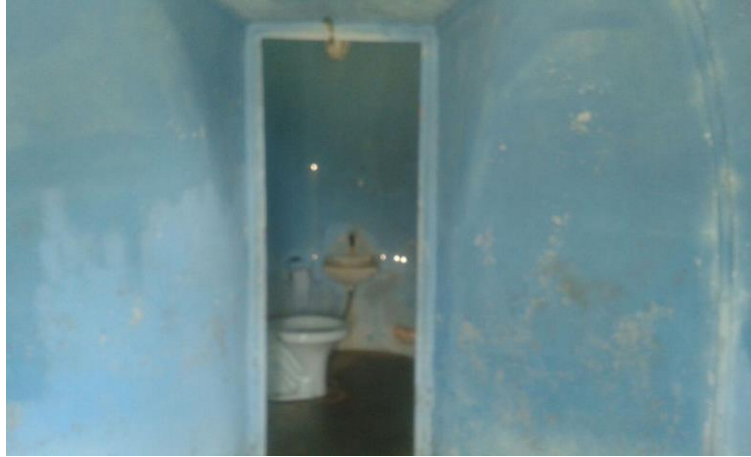
PORTA INTERNA DO SANITÁRIO MASCULINO - PARQUE DO JD. PANAMBI
