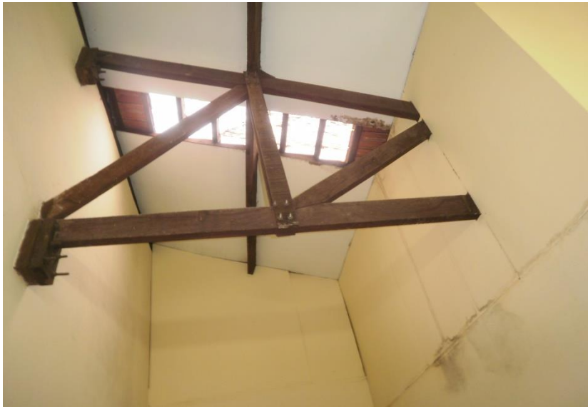
Telhado da cozinha
