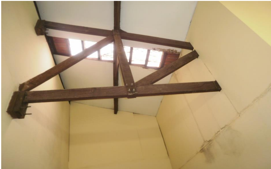
Telhado da cozinha
