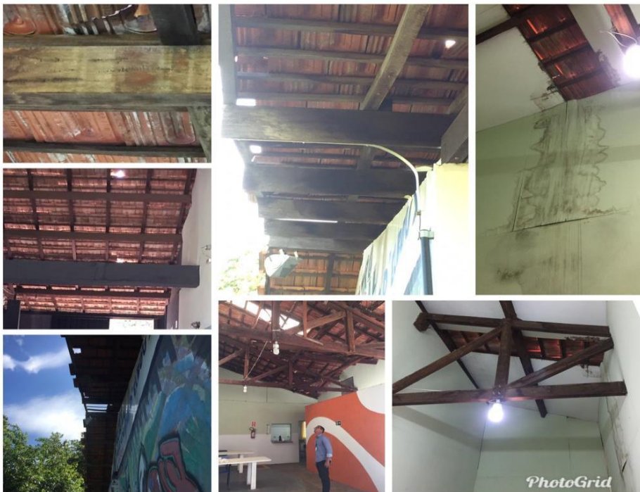
Telhado do prédio
