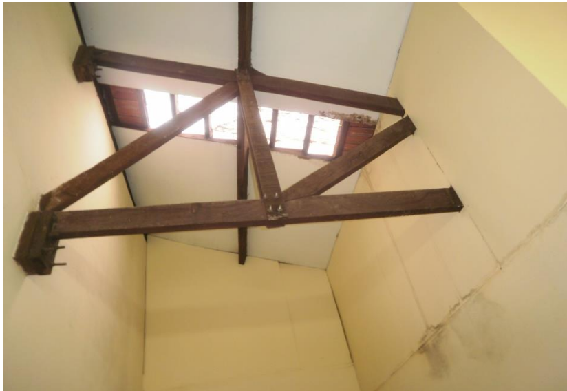
Telhado da cozinha
