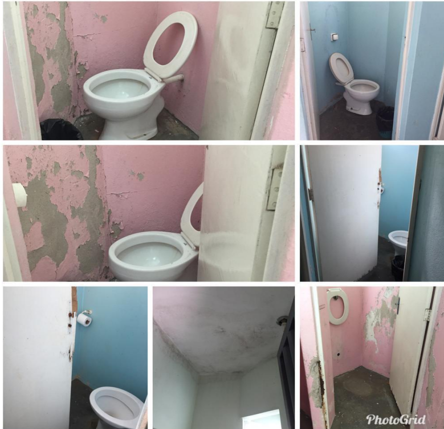
Área do Banheiro masculino e feminino
