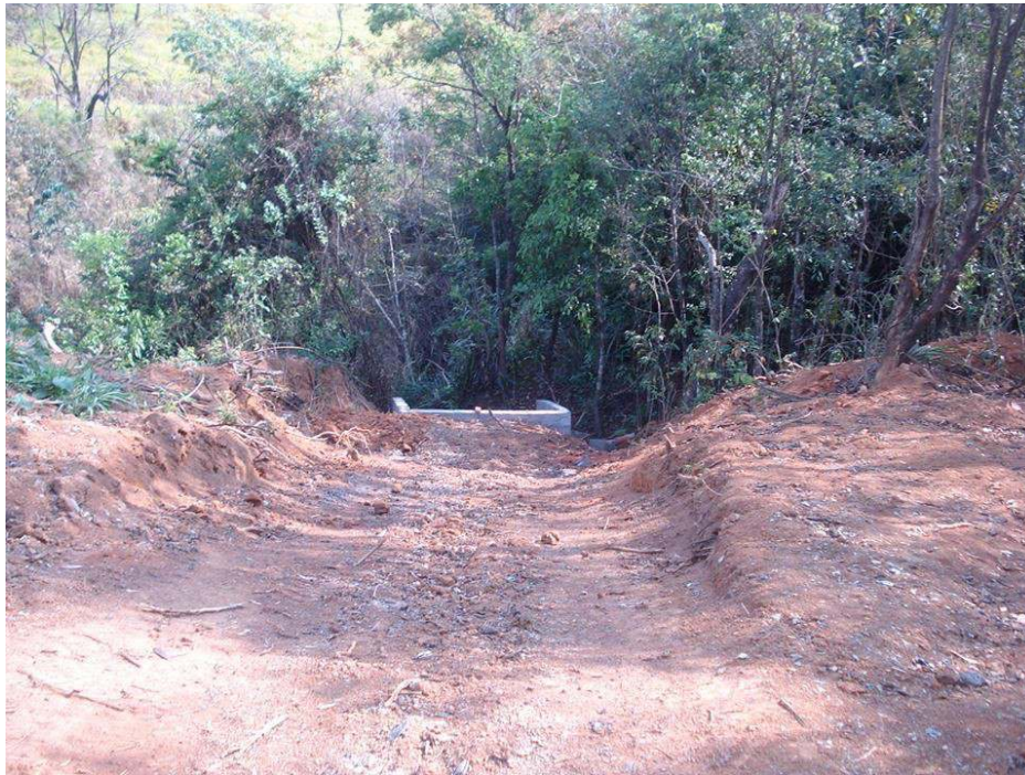
Galeria de águas sendo construída no local.
