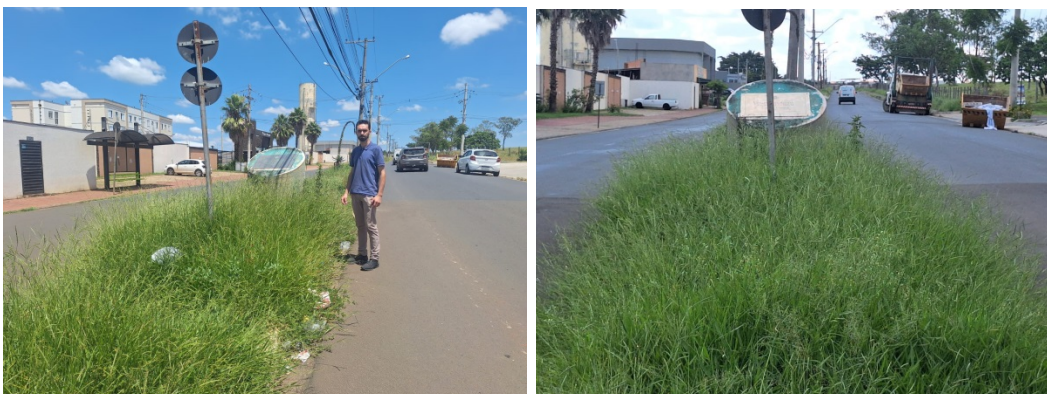
Base de concreto da placa da obra é muito grande e atrapalha a visão dos motoristas.
