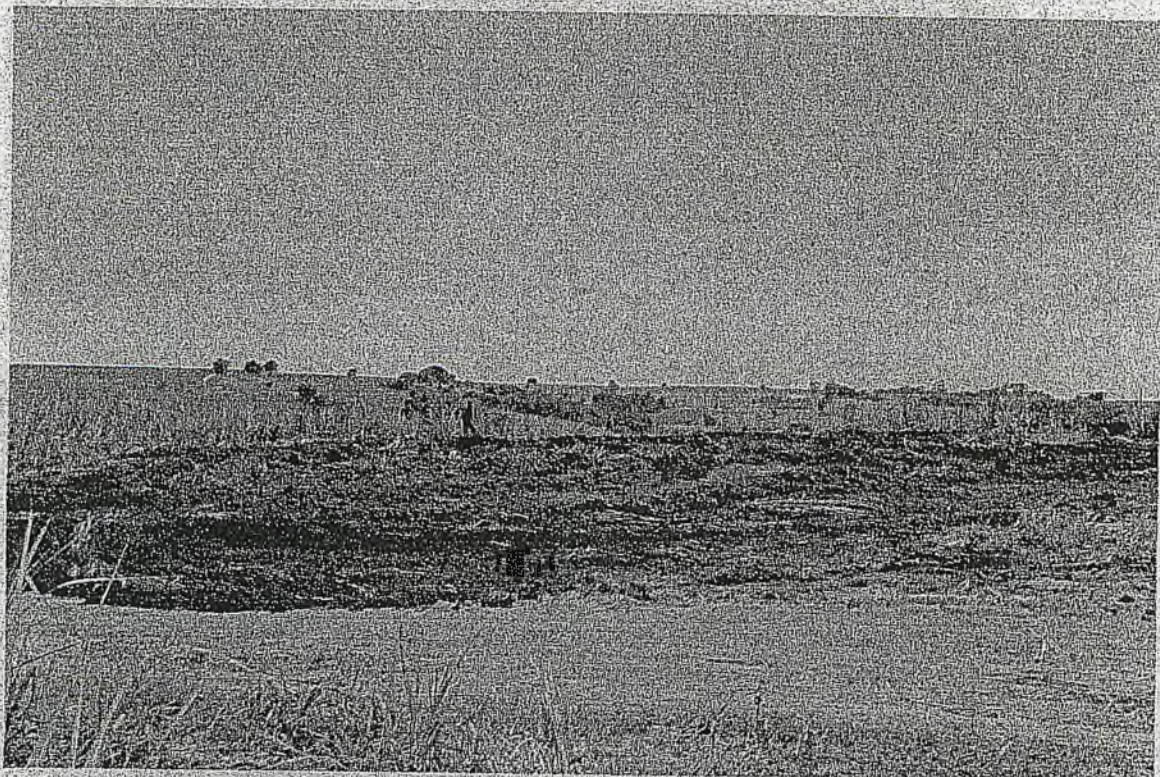
Lançamento de lodo no local
