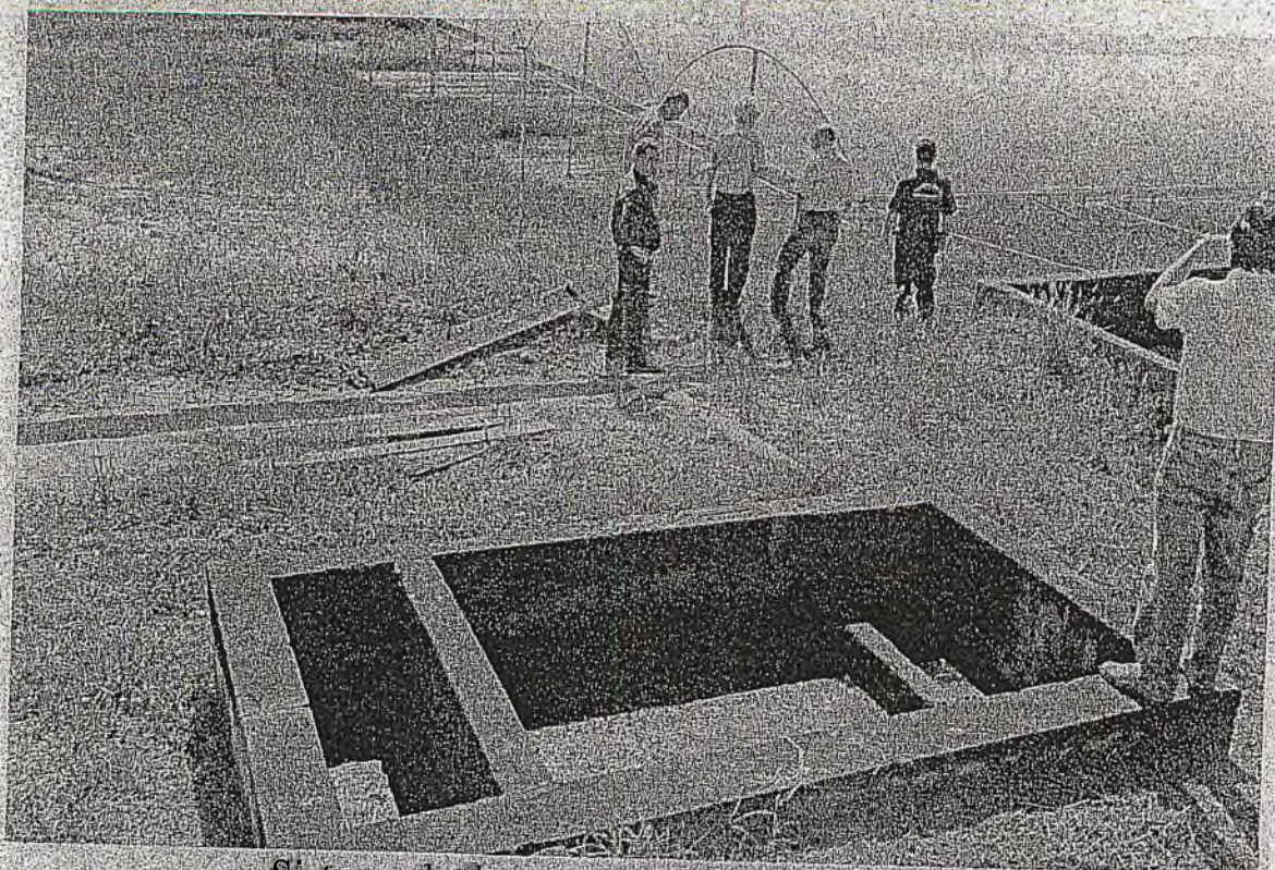
Sistema de decantação de líquido percolado
